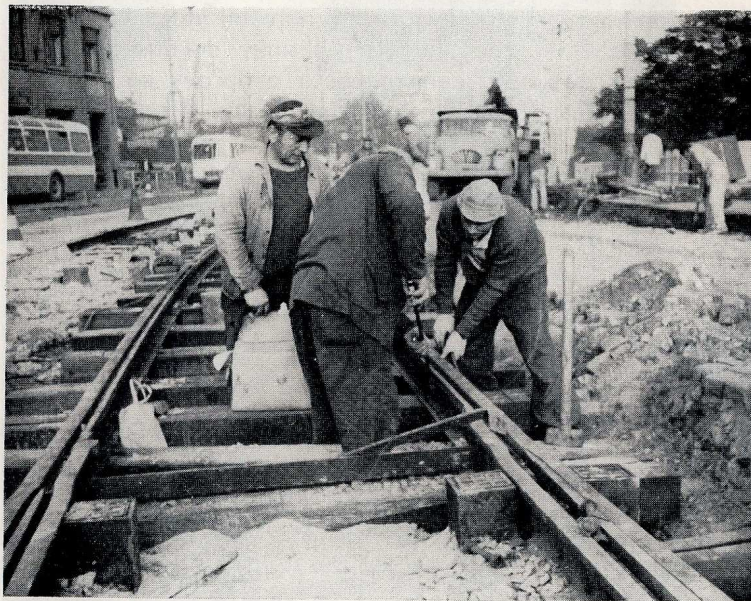
Pravidelnou údržbu vyžaduje i kolejová síť
