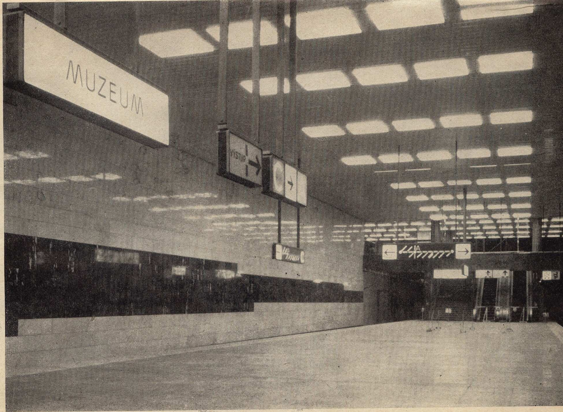
Důležitá křižovatka METRA. Pod touto stanicí se buduje stanice trasy A
