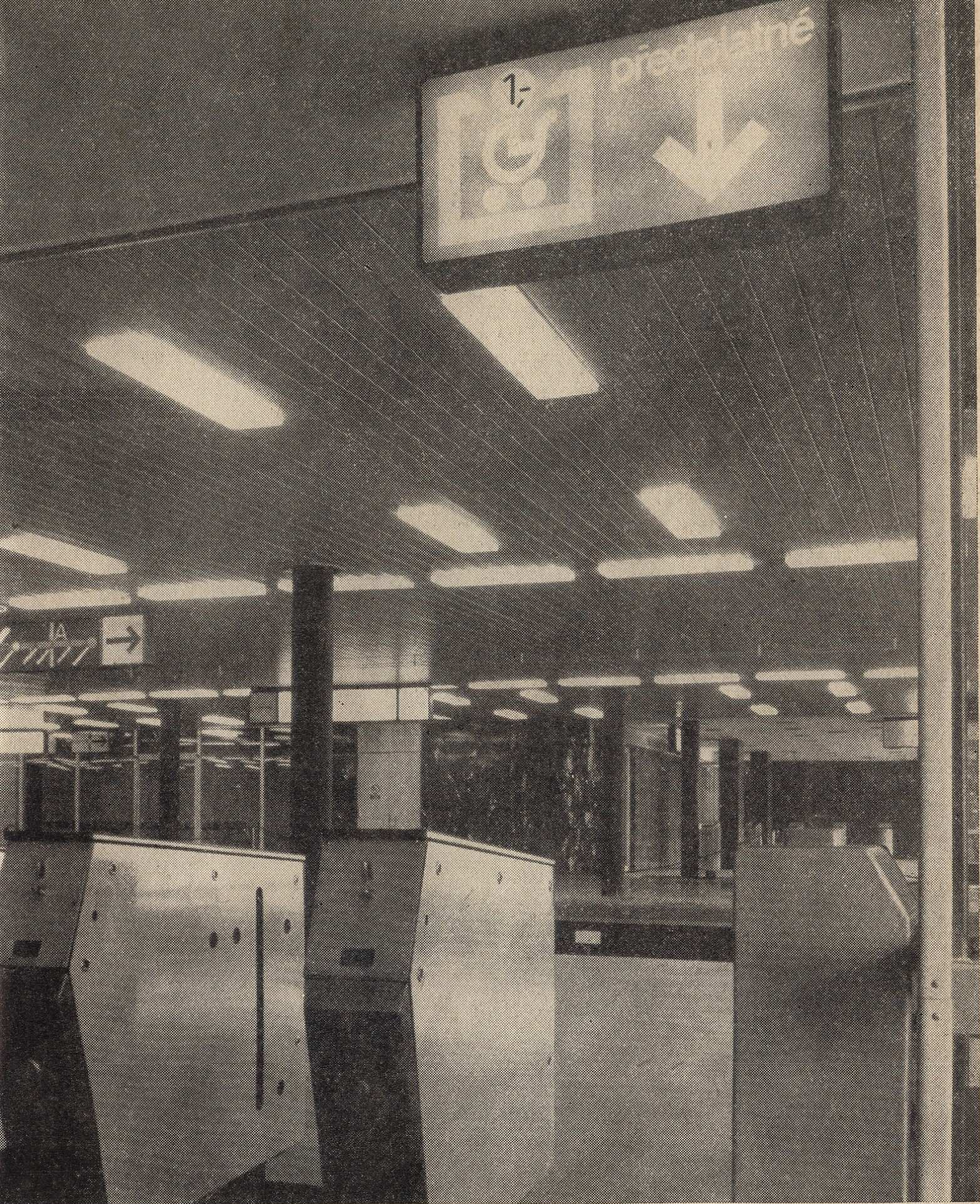
Turnikety před vstupem do provozních hal
